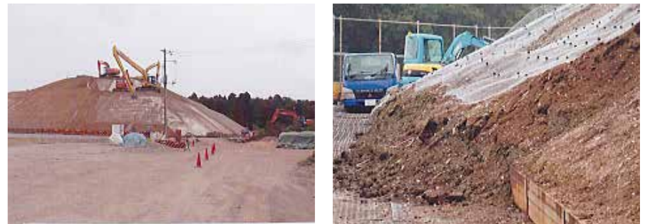
崩れないようにネットを貼りセメントを混ぜた砂を貼り付けていくところ。
